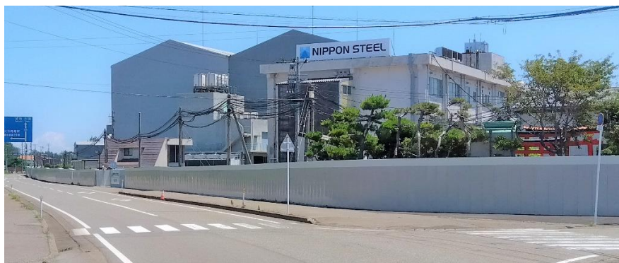
＜鋼製遮水壁 外観＞
