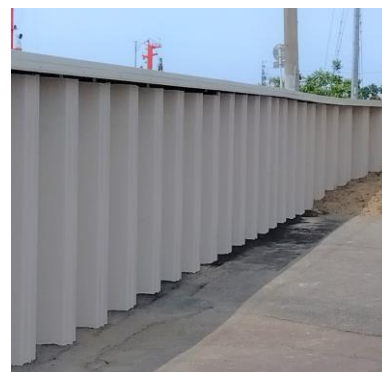
＜鋼製遮水壁 内側＞
