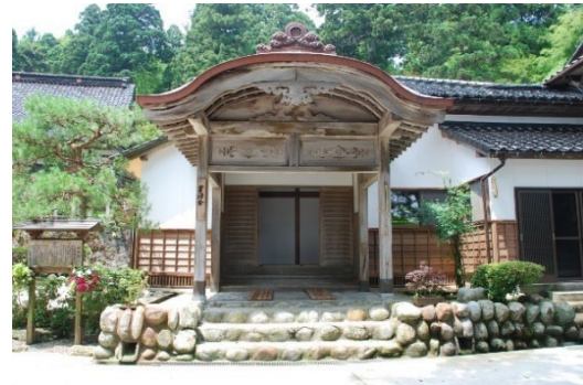
青林寺客殿（和倉御便殿本殿）
