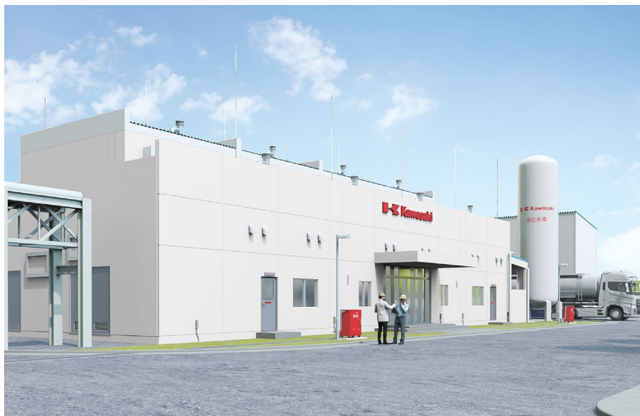
液化水素関連機器試験設備の完成イメージ
