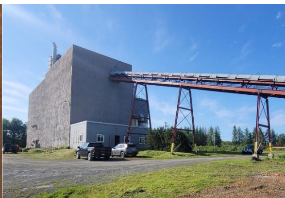
KAP 社の既存選鉱設備
