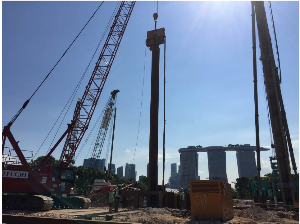
写真 2. ハット+H の打設状況
