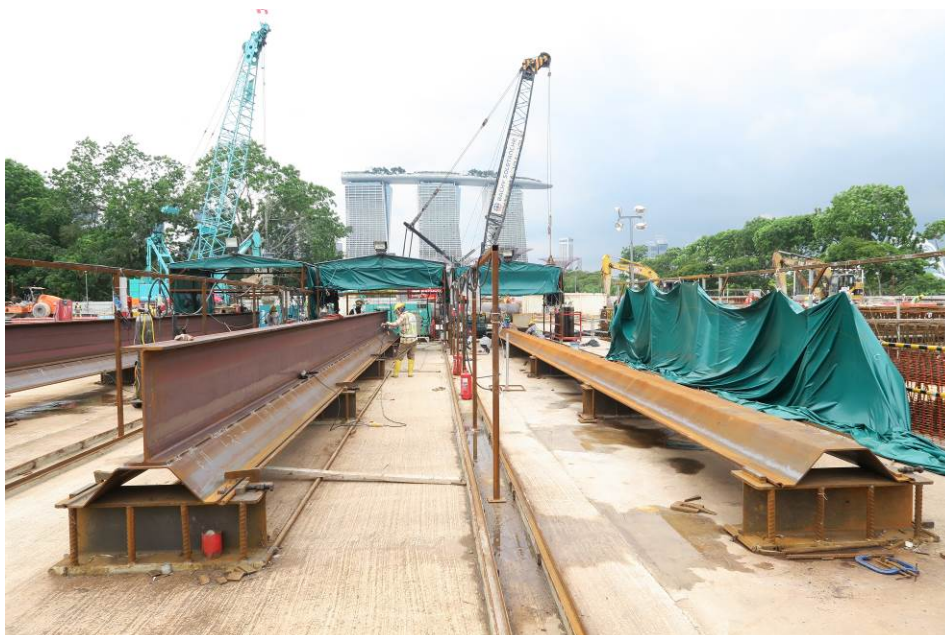
写真 1. 施工現場における Hat+H の加工状況
