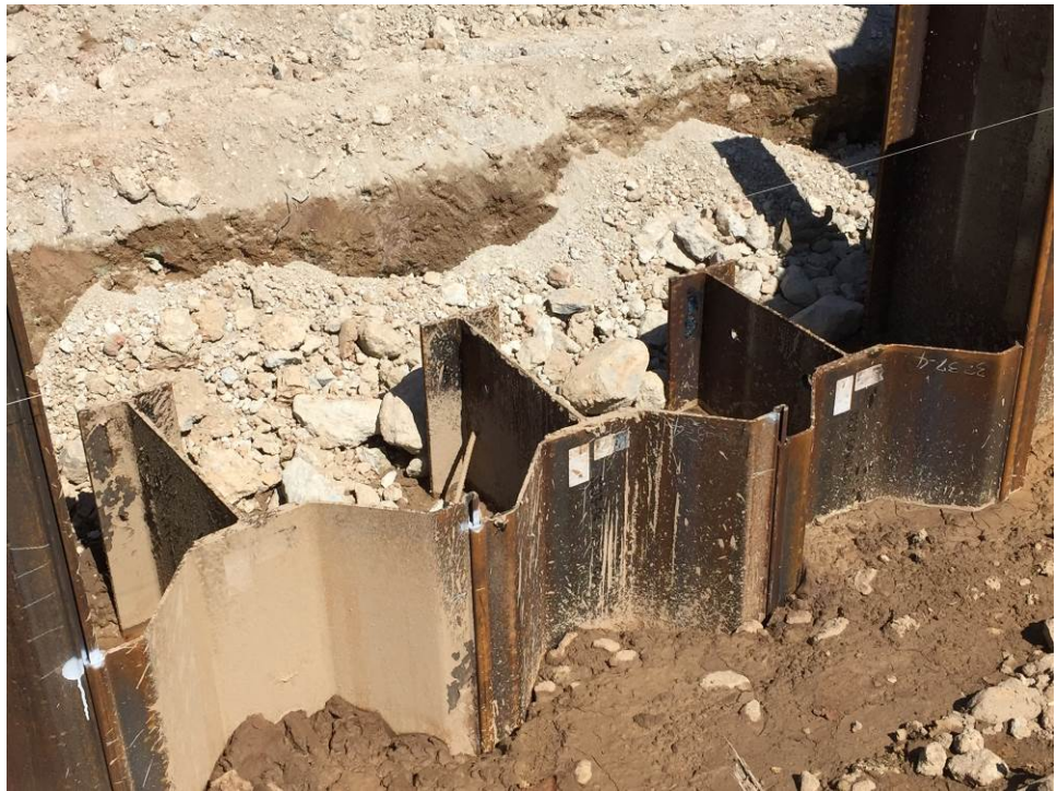
写真 3. 打設後のハット+H の状況
