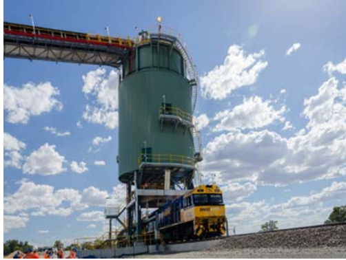
鉄道積込設備
