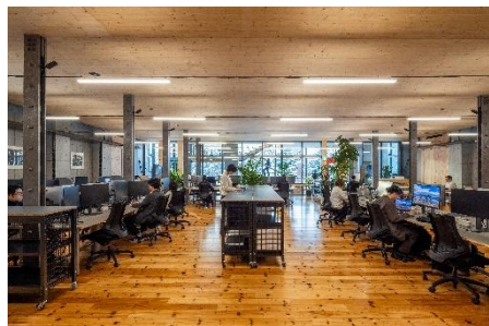
＜執務室天井に表しの 北海道産トドマツ構造CLT＞
