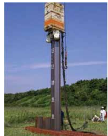
図 3 鋼矢板の打設
