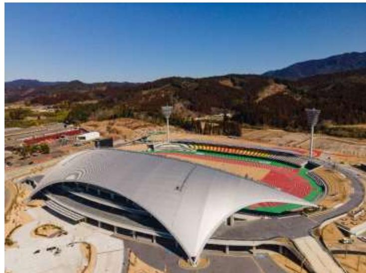
今回採用されたSUS445J2は、汎用オーステナイト系高耐食ステンレス鋼であるSUS316を超える耐食性を持ちながら、レアメタルであるニッケルを含まない省資源ステンレス鋼であり、価格安定性に優れています。加えて、フェライト系ステンレス鋼の線膨張係数は一般的なオーステナイト系ステンレス鋼の約6割であり、温度変化に伴う変形やひずみが抑制されるため屋根の長寿命化が可能になります。
