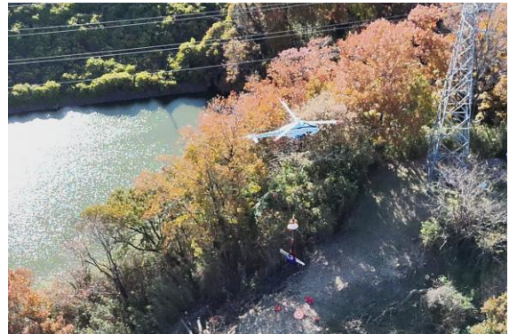
（右）送電鉄塔の近くで荷降ろしする様子
