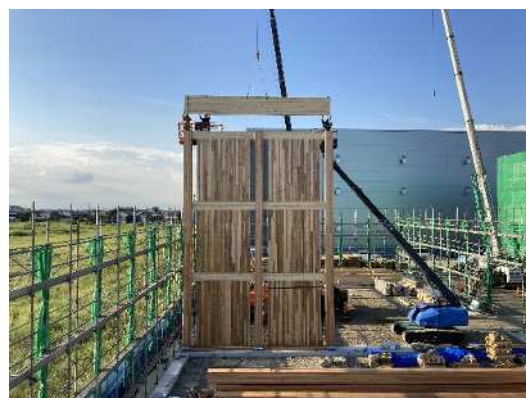
【CLT ノンビス耐力壁】
