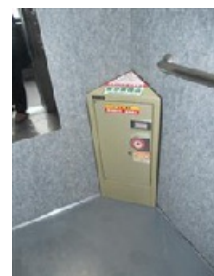
エレベーターに 緊急装備品を設置
