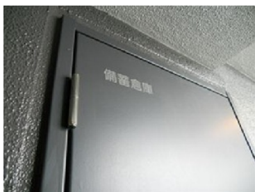
防災備蓄倉庫の設置
