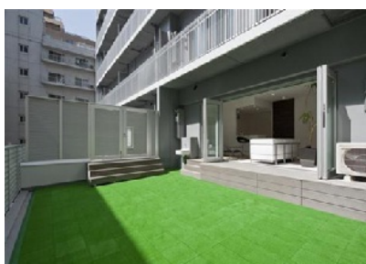
2階住戸にルーフテラス(人工芝)の設置
