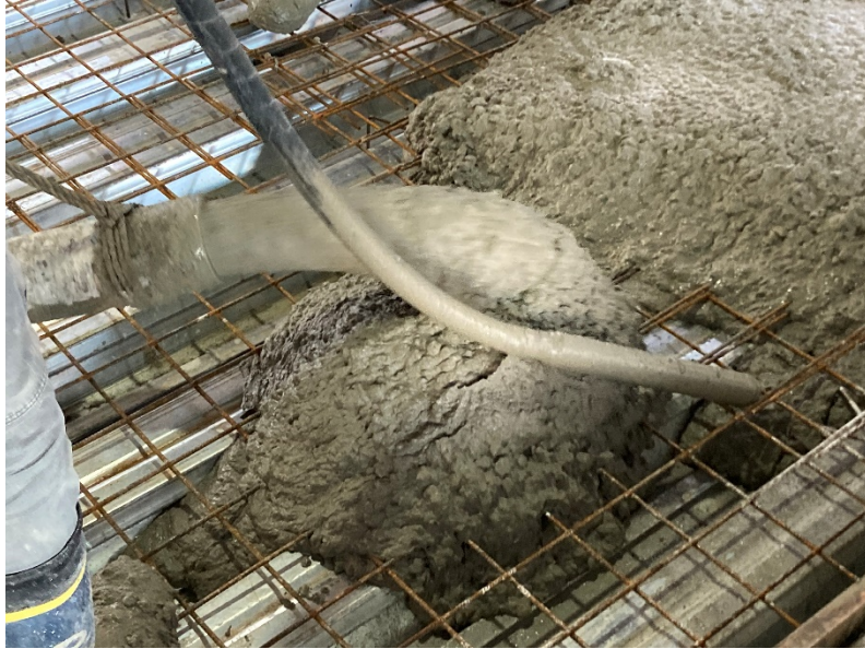
▲コンクリート打設状況
