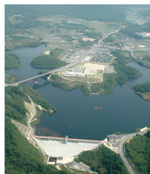
小水力発電 小水力発電所の 設置に対する補助
