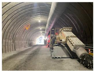
■写真左:トンネル工事の切羽(きりは)での掘削状況
